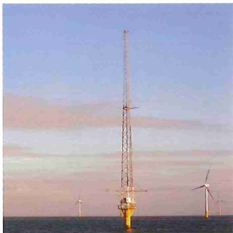
Meting van windprofielen boven zee geeft inzicht in gedrag van de grenslaag
